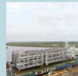
Piperack Modules (PAR)
